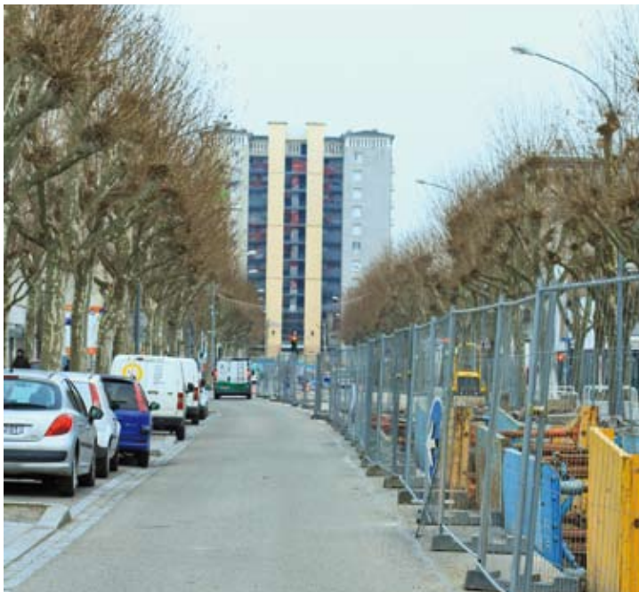
■ Au bout de l'avenue de Normandie, la tour 28 sera démolie en juin.
